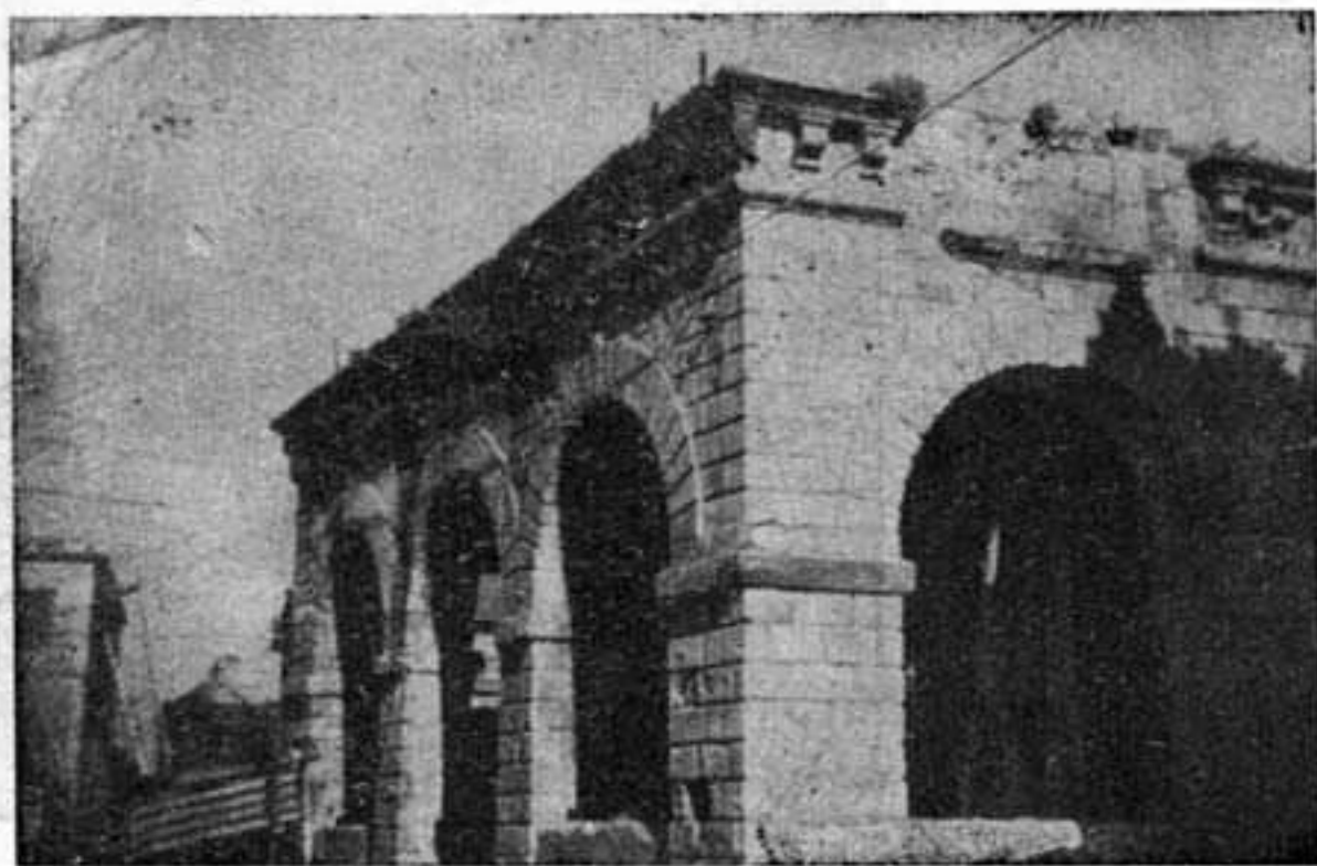
Εἰκ. 29. Ἔργασίαι ἀναστηλώσεως Ἐνετ.Λέσχης Ρεθύμνης.
