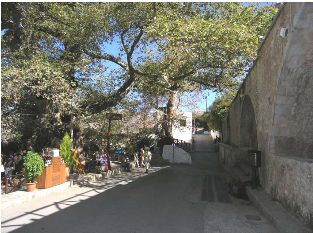
Εικόνα 7: Το τμήμα της οδού και η κατασκευή των θολωτών δεξαμενών από νότια (Οκτ. 2006)
